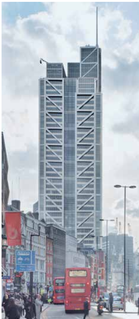
Heron Tower, London, Velika Britanija BREEAM Izvrsnost
